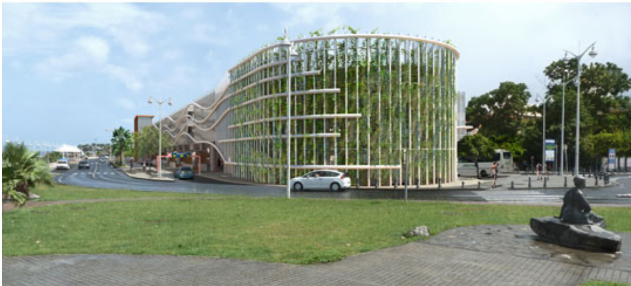
Stationnement intégrant la végétation pour camoufler la façade
