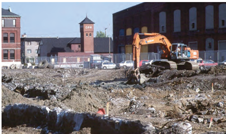
Travaux de décontamination
