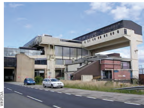
Immeuble multifonctionnel du centre-ville de Cumbernauld Écosse.
