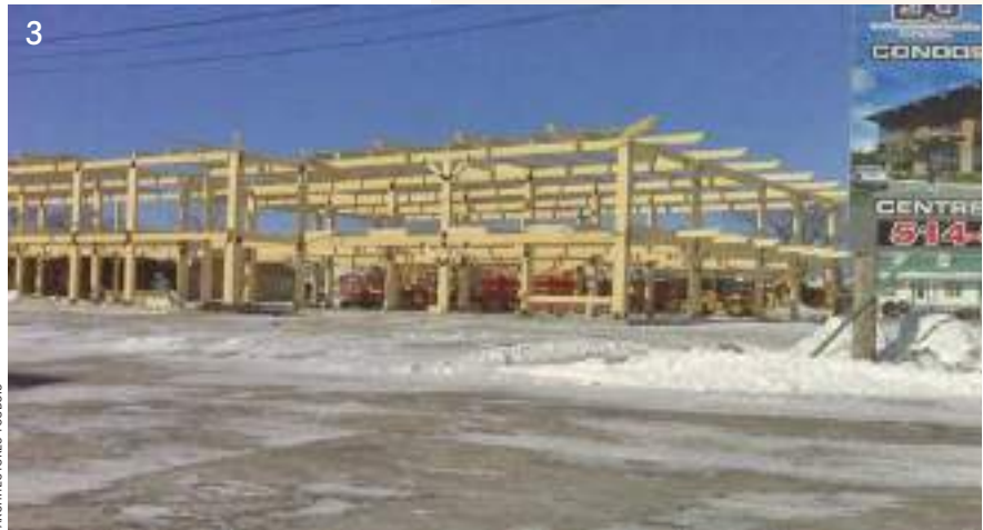
PHOTO 3 Construction de condos commerciaux avec armature en bois, Ville de Laval
