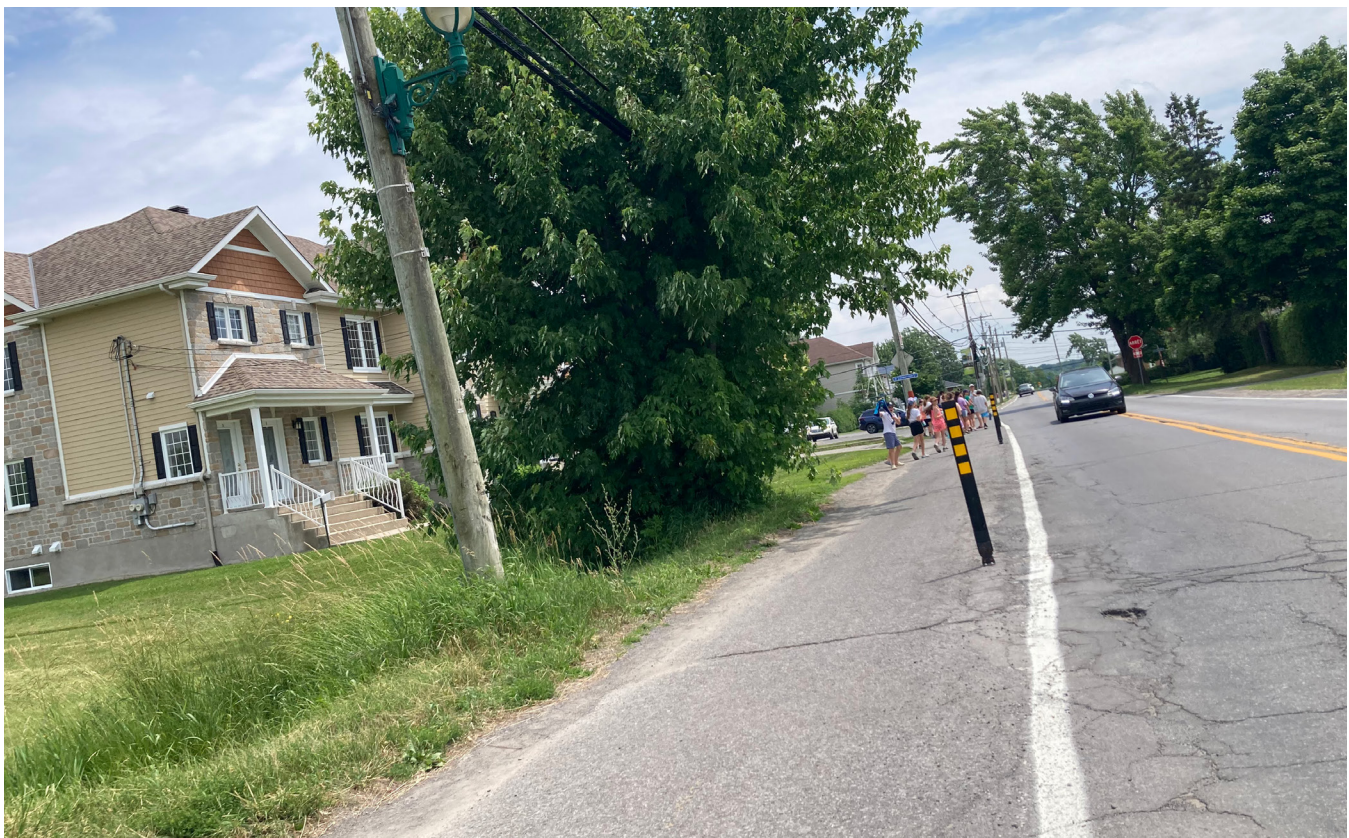
Accotement séparé par des bollards.
