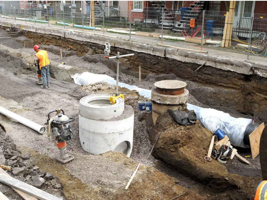
Modernisation des réseaux pour gérer les pluies et prévenir les inondations.
