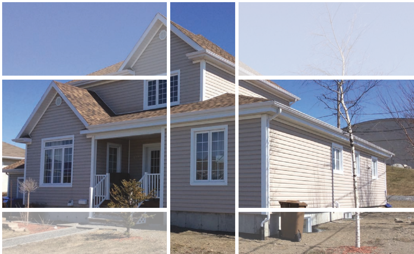
Habitation unifamiliale transformée par l'ajout d'un logement intergénérationnel dans le district Rimouski-Est. La porte a été ajoutée à l'arrière et l'agrandissement a été créé dans un souci d'intégration par le choix des matériaux, des fenêtres, des volumes.
