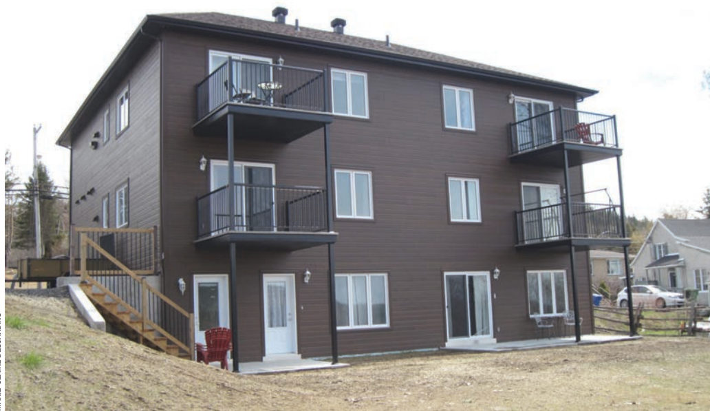
Au Bic, la topographie du terrain a permis d'intégrer le 5e logement au demi sous-sol avec entrée à l'arrière. L'aspect architectural d'un 4 logements a été conservée en façade dans un souci d'intégration au milieu villageois.
