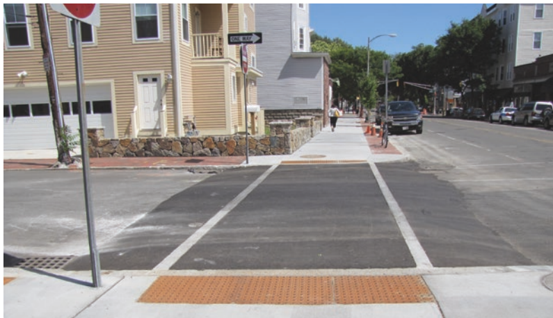
Une traverse piétonne surélevée avec des plaques podotactiles.
