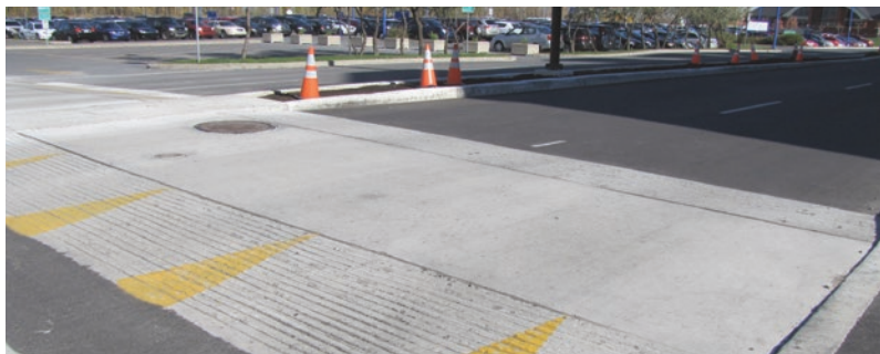
Une traverse piétonne surélevée en béton, qui indique instinctivement que le piéton a priorité.
