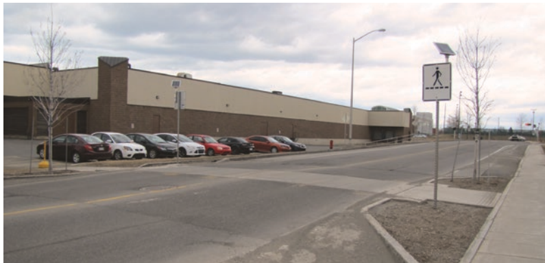
Une traverse piétonne surélevée mise en place pour favoriser l'accès des aînés à un centre commercial.
