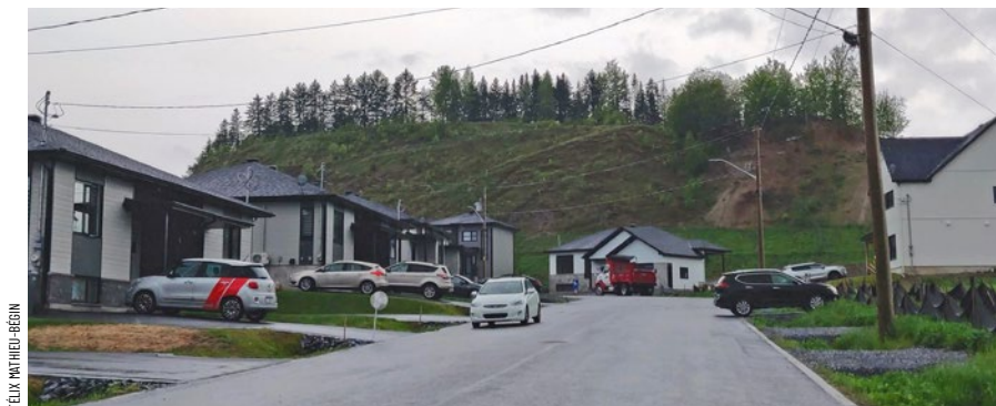
Nouveau quartier du Coteau des sables avec mur antibruit.
